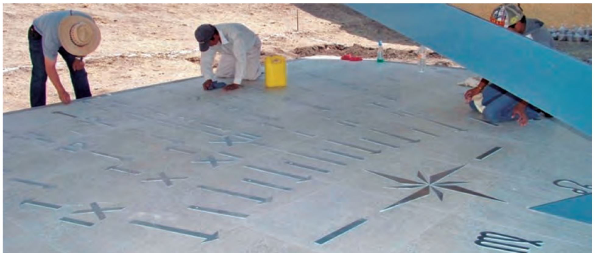
Colocación de los símbolos de acero inoxidable sobre la carátula.
